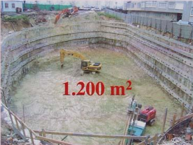
Hafriyat tamamlandı, İksa sisteminde son kademeye inildi.
