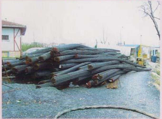
Temel betonunu atmak için hazırlıklar hızlandı. 250 ton demir hazır
