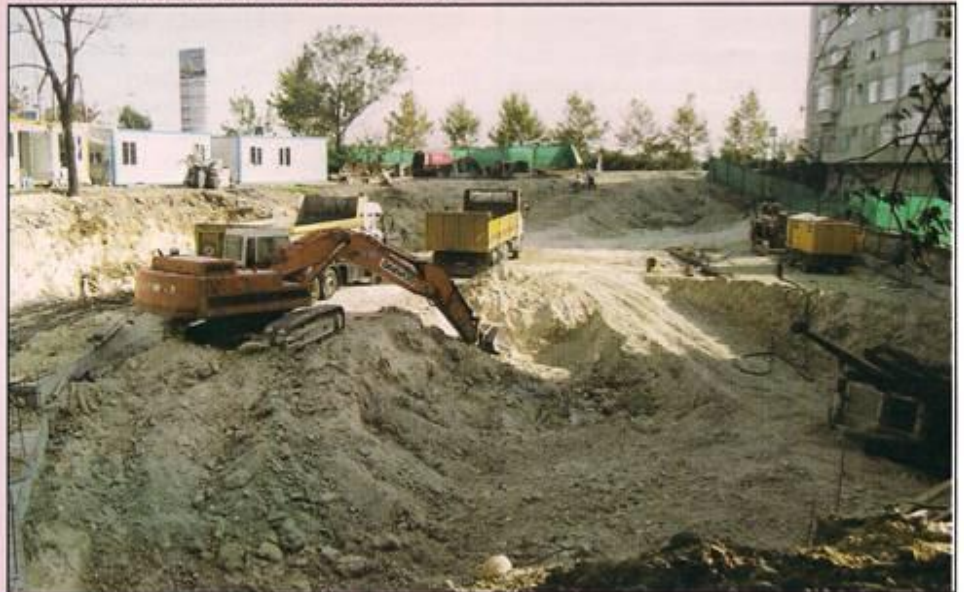
İnşaat alanında çalışmalar hızla devam ediyor.
