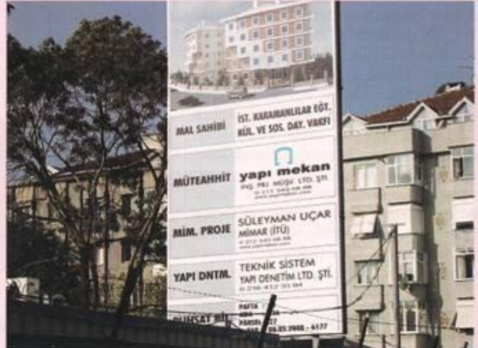
İnşaat alanımıza tabelamızı astık.
