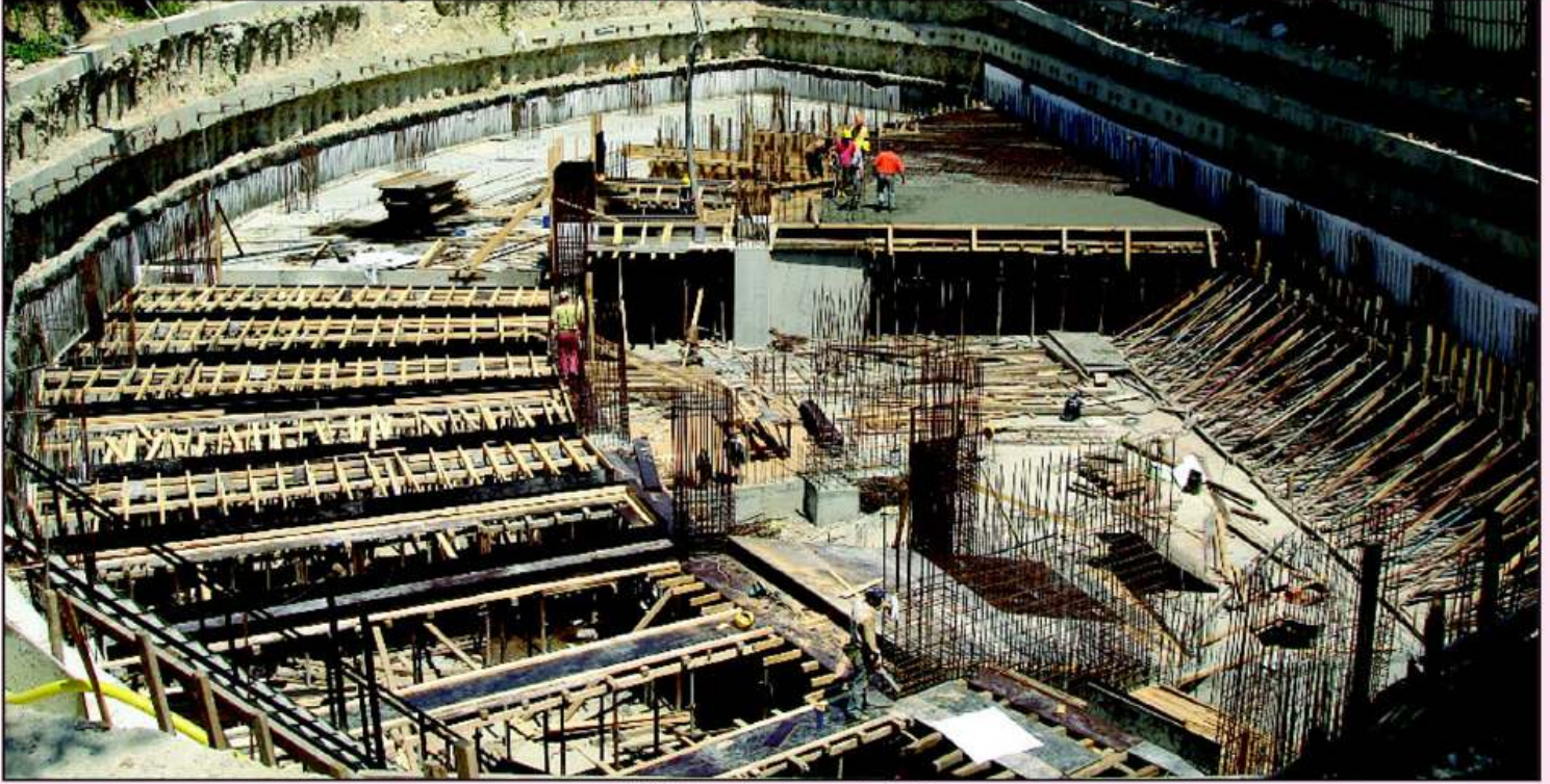
Dördüncü yarım katın betonu atılmadan önce
