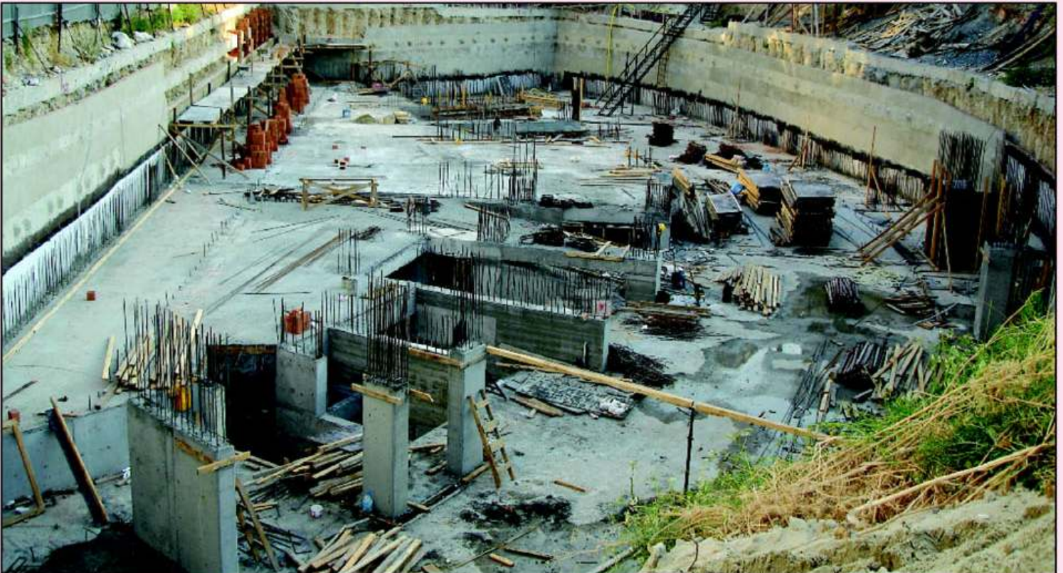
Dördüncü yarım katın betonu atıldıktan sonra
