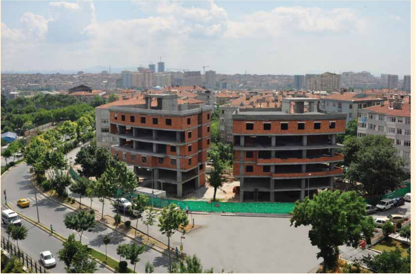
Karamanlılar Evi inşaatımızın Bakırköy Adalet Sarayından görünüşü
