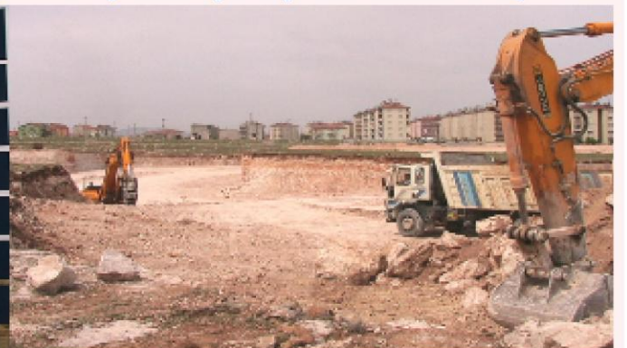
İnşaat alanının görüntüsü
