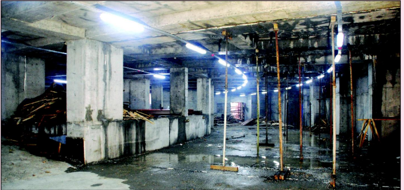
Karaman Evi İnşaatımızın 3 katlı kapalı otoparkında sulu yangın sistemi ve havalandırma sistemi çalışmaları devam ediyor
